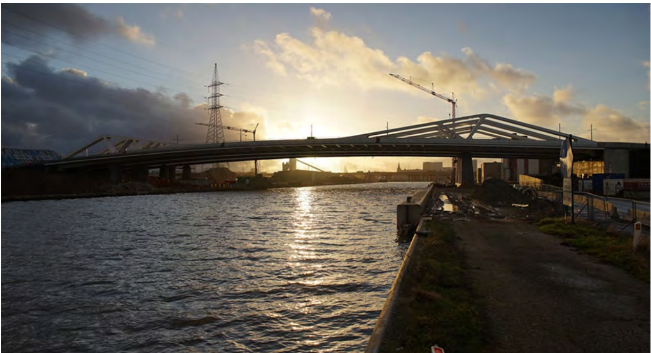
De nieuwe Theunisbrug over het Albertkanaal
